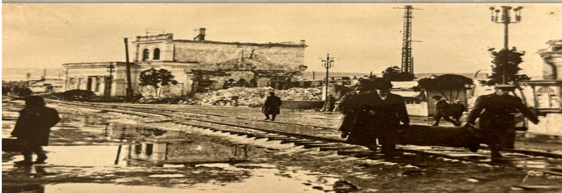
Разрушенный вокзал Симферополя сразу после освобождения. 1944 год
